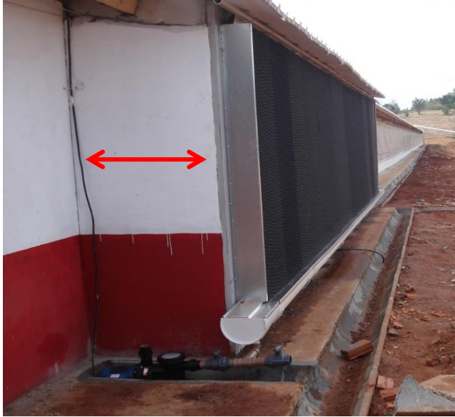
Instalación del Panel evaporativo: Dog House.
